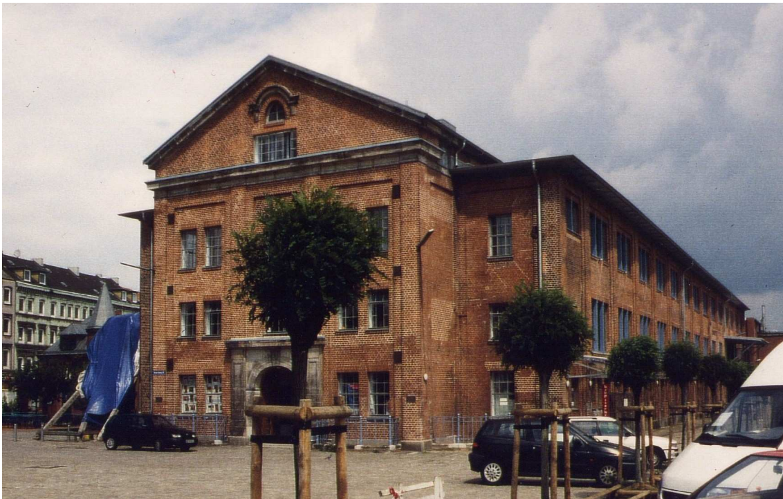
Abb. 2: Etage 2 - Gründerzentrum in einer ehemaligen Rinderschlachthalle im Stadtteil Karolinenviertel/St.Pauli
