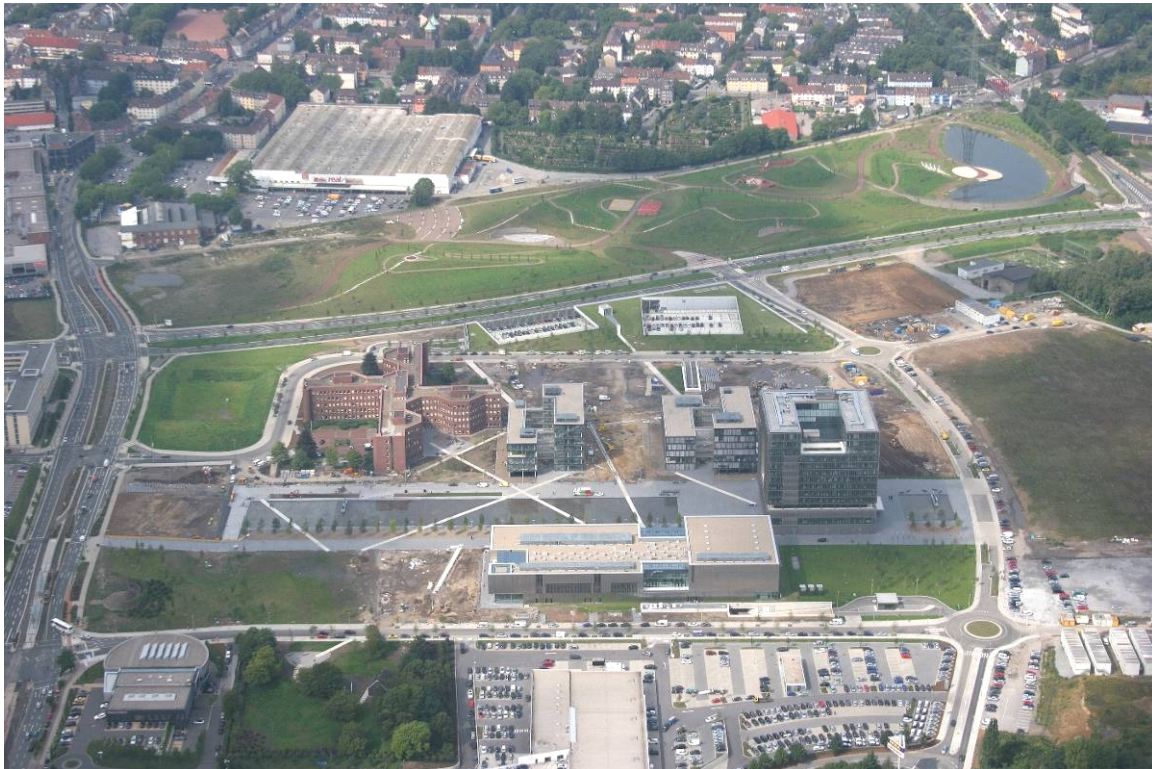
ThyssenKrupp-Quartier und Krupp-Park Essen, 2010
